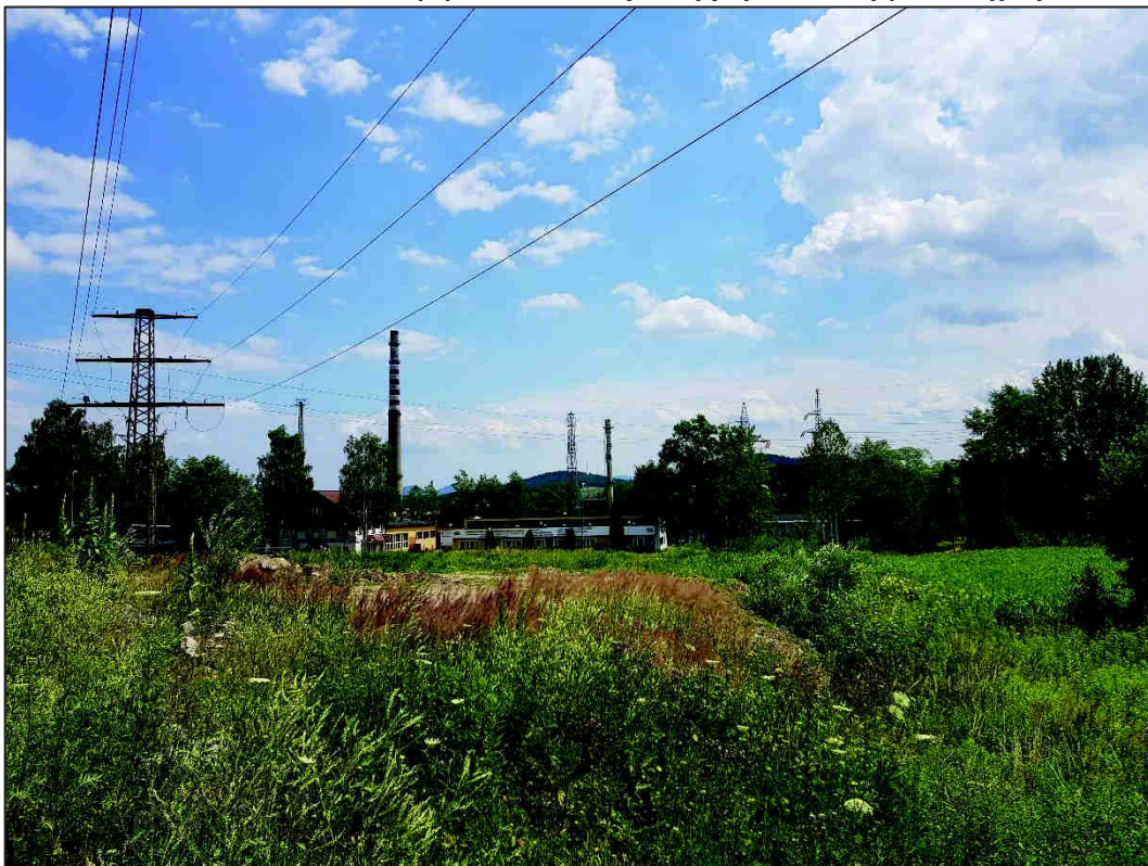
Fot. 3. Widok z obszaru mpzp w kierunku sąsiadującej zabudowy produkcyjnej.
