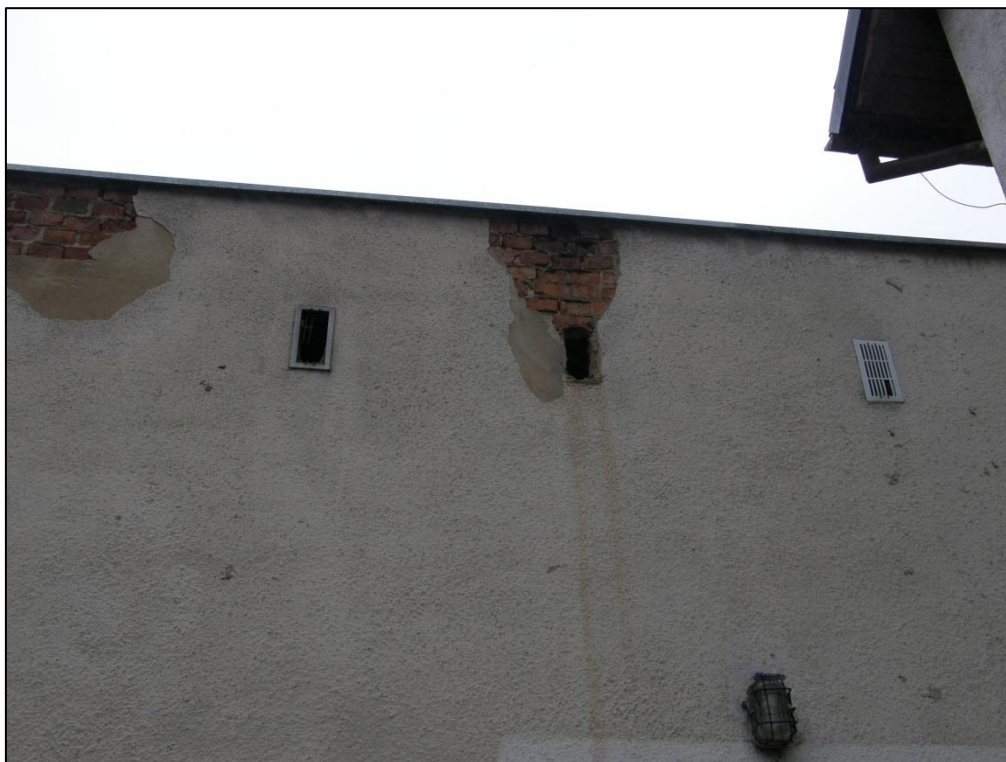
Fot. 7. Otwory wentylacyjne wymagające zabezpieczenia siatką.
