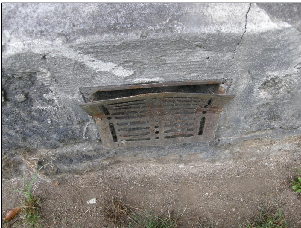
Fot. 8. Jeden z otworów wentylacyjnych wymagających zabezpieczenia siatką.
