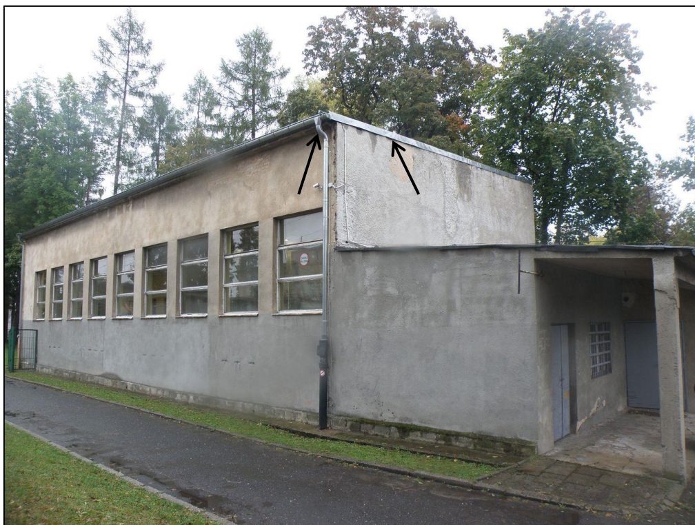
Fot. 10. Sala gimnastyczna Zespołu Szkół Rzemiosł Artystycznych – widok od tyłu (wjazd na parking). Przy rynnie i pod obróbką blacharską dachu stwierdzono szczeliny, mogące być wykorzystywane przez nietoperze.
