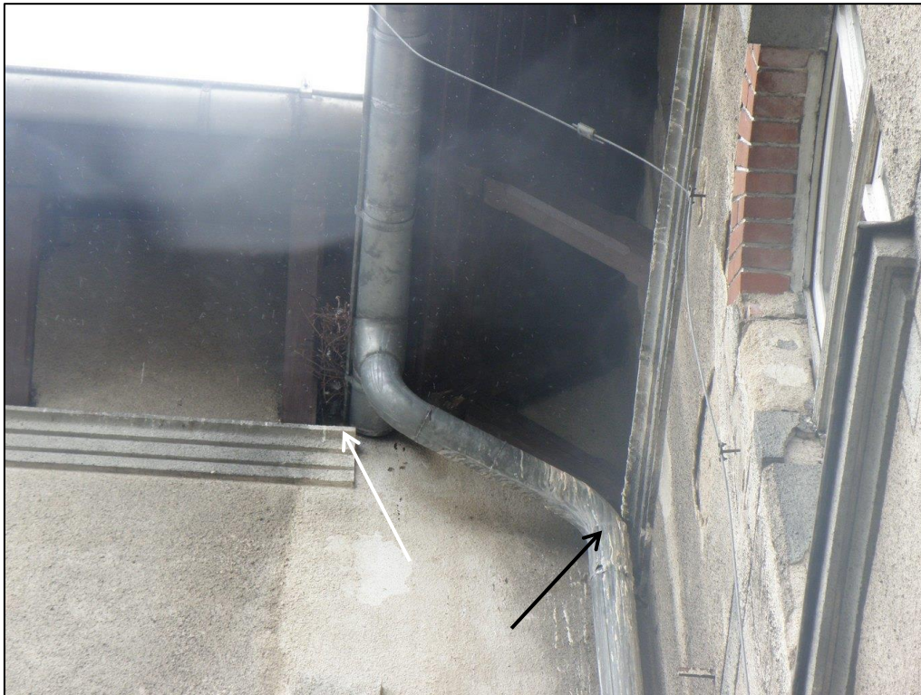
Fot. 5. Tył budynku A. Gniazdo oraz odchody gołębi miejskich na rynnie.
