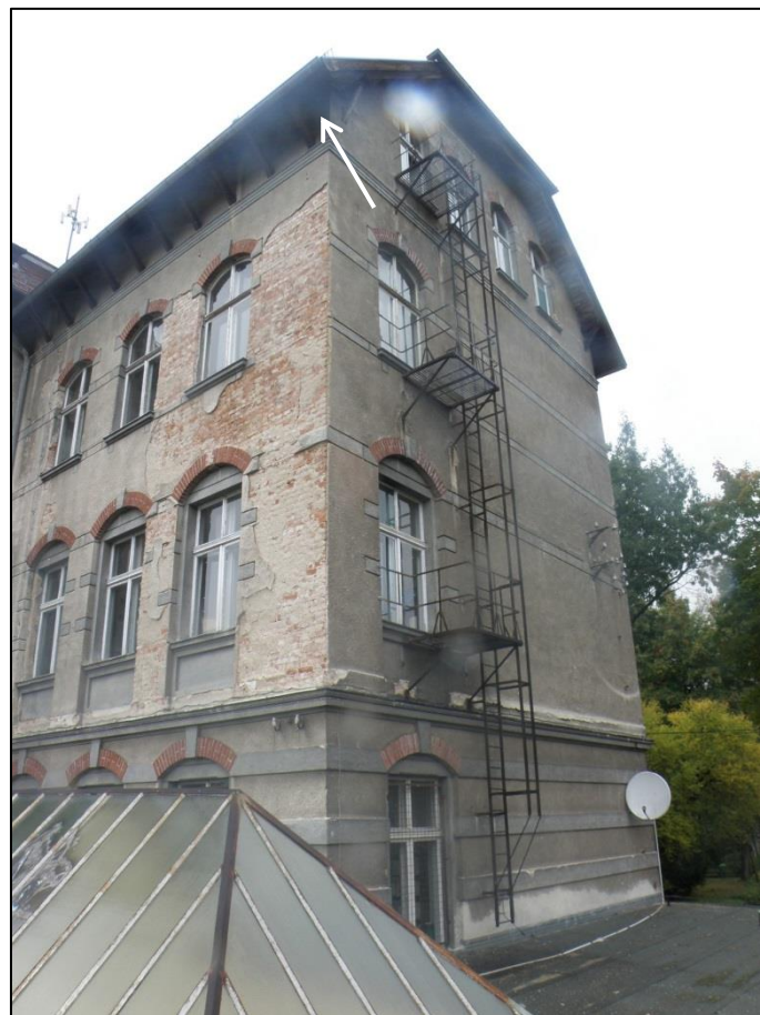
Fot. 6. Boczna ściana (wschodnia) budynku A. Na drewnianych belkach, tworzących okap stwierdzono odchody gołębi miejskich.
