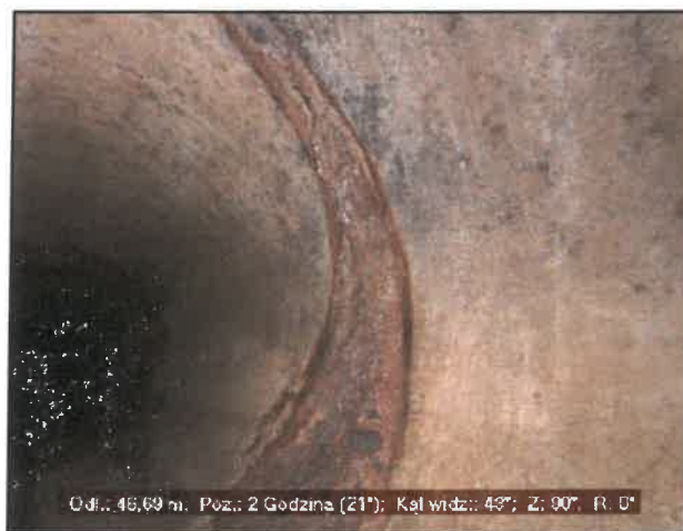
Zdjęcie 018 Taśma wideo: P-027-2016 Stan BBF A 46,69 m 3 - 2 Zegar; Kl: 3 Infiltracja, pocenie
