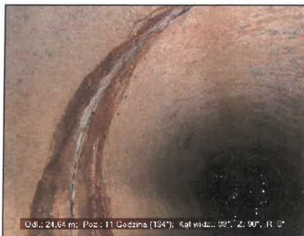
Zdjęcie 017 Taśma wideo: P-027-2016 Stan BBF A 24,64 m 11 Zegar; Kl: 0 Infiltracja, pocenie
