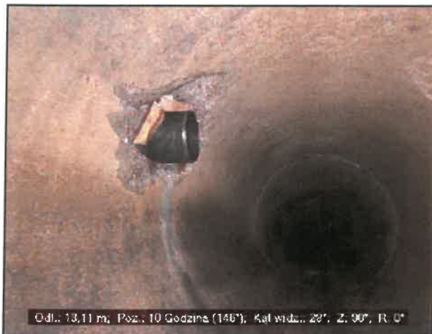
Zdjęcie 015 Taśma wideo: P-027-2016 Stan BAG 13,11 m 10 Zegar; Kl: 0 Połączenie wystające, Wystająca długość = 15%
