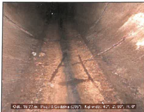
Zdjęcie 016 Taśma wideo: P-027-2016 Stan BAF H E 16,77 m 6 Zegar; Kl: 0 Uszkodzenie powierzchniowe, skorodowane zbrojenie, przyczyna nie jest jednoznaczna
