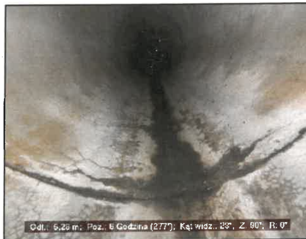
Zdjęcie 029 Taśma wideo: P-028-2016 Stan BAB B C 5,28 m 6 Zegar; Kl: 0 Szczelina, pęknięcie, złożone, Szerokość = 10mm
