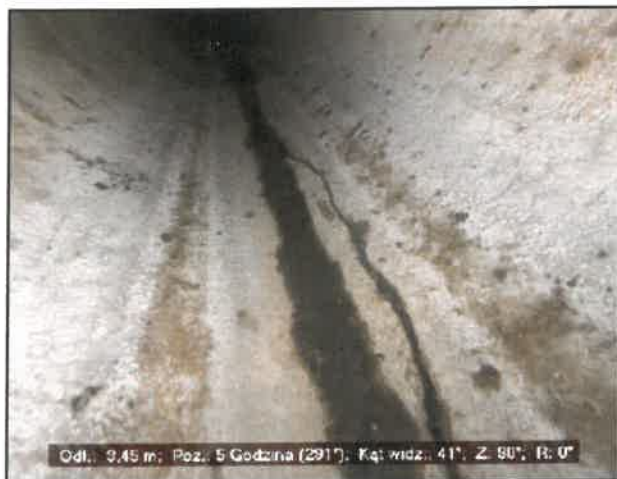
Zdjęcie 028 Taśma wideo: P-028-2016 Stan BAB B A 3,45 m 5 Zegar; Kl: 0 Szczelina, pęknięcie, wzdłużna, Szerokość = 15mm
