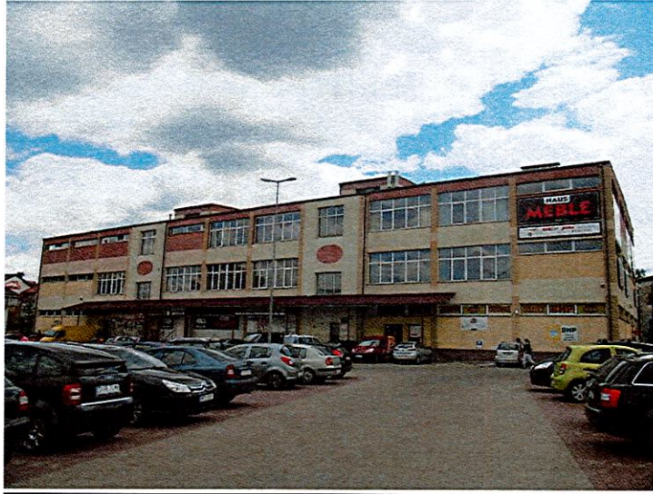
Zal. nr 1: Widok ogólny instalacji radiokomunikacyjnej.
