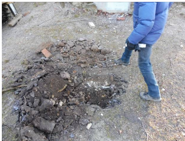
Fot. nr 3. Odkrywka w miejscu posadowienia nieistniejącego ganku wejściowego (fragment ściany ceglanej).
