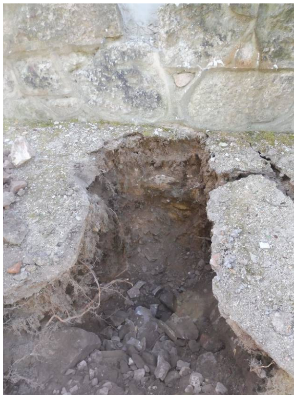
Fot. nr 2. Odkrywka w miejscu posadowienia wieży.
