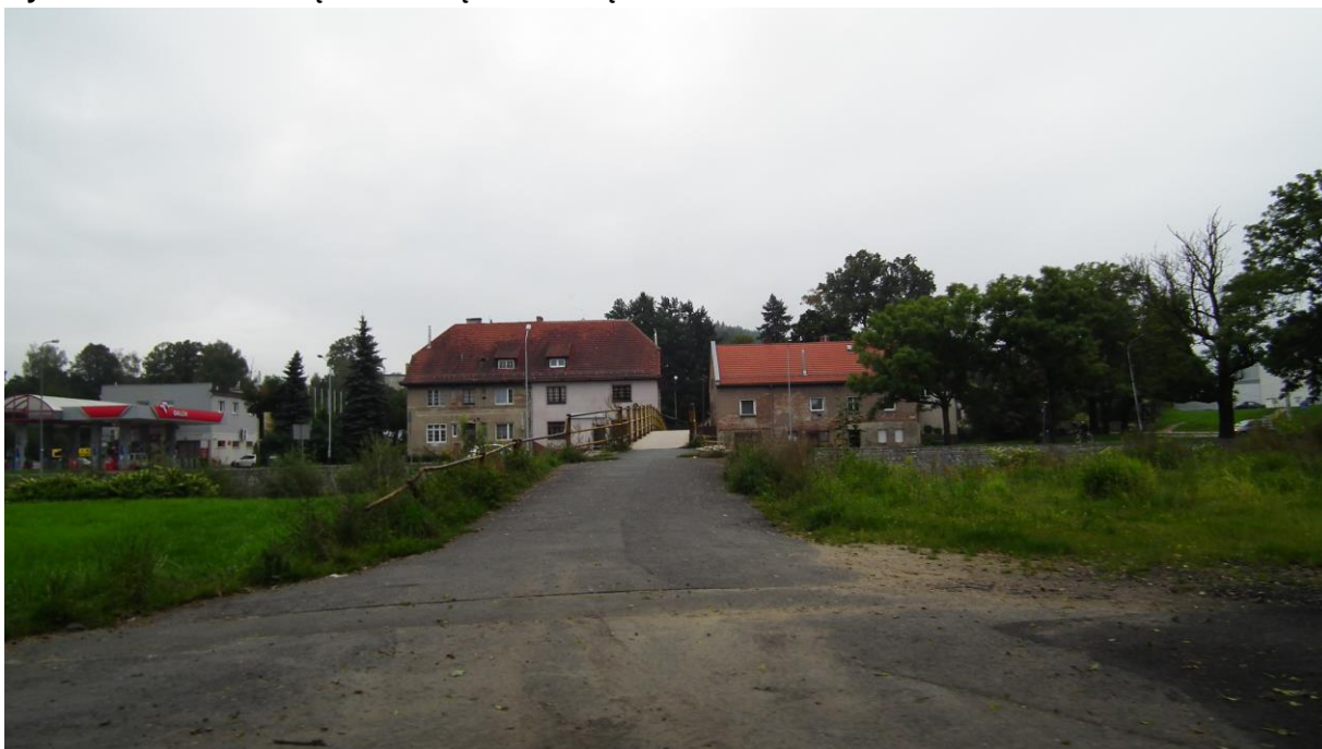
Ryc. 4 Widok na kładkę nad rzeką Kamienną
