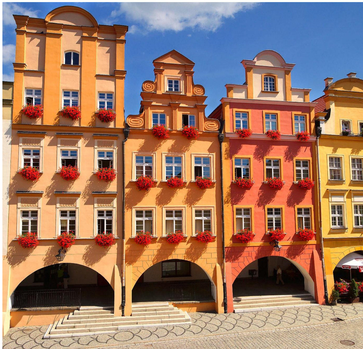
Zdjęcie 8. Kamienice na Placu Ratuszowym w Jeleniej Górze
