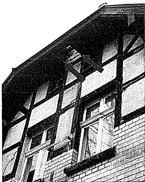
Fot. 8. „Półki” powstałe w drewnianej podbitce dachu, na skutek ubytku desek stanowią potencjalne miejsce na założenie gniazda.
