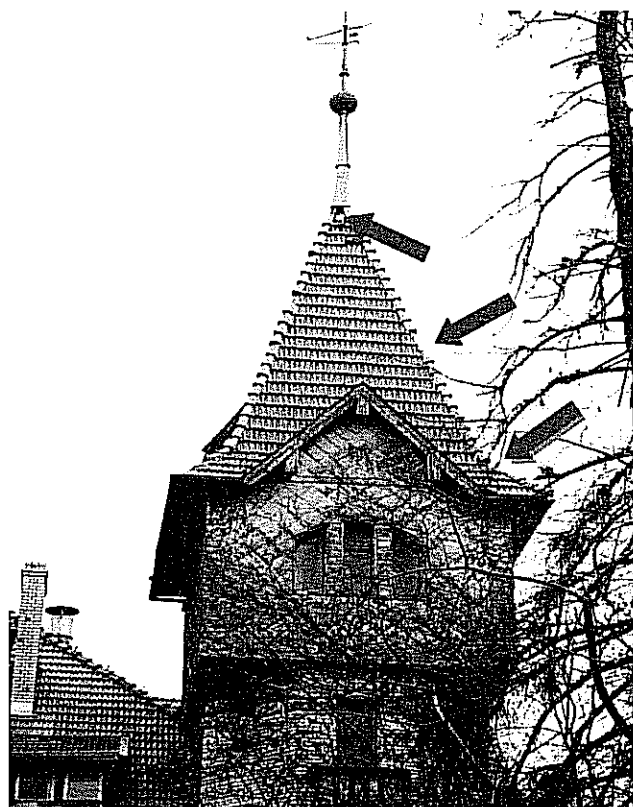
Fot. 1. Otwory po zniszczonych dachówkach umożliwiają ptakom wchodzenie do środka wieży. Wieża stanowi schronienie i miejsce gniazdowania około 20 kawek.
