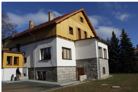
Miejskie Przedszkole nr 11 po termomodernizacji
