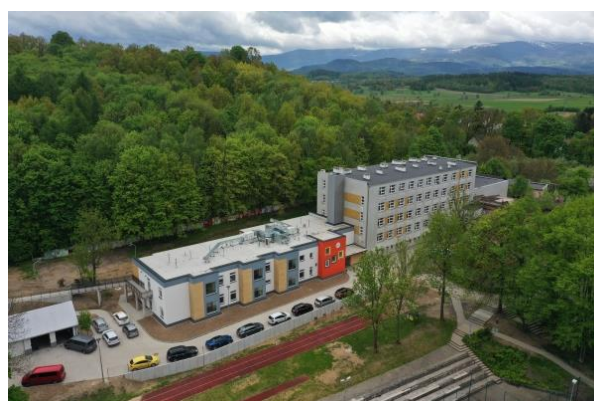
Budowa Zespołu Edukacji Przedszkolnej i Podstawowej dla dzieci niepełnosprawnych przy ulicy Kruszwickiej
