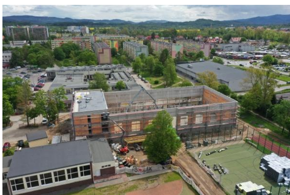
Budowa hali sportowej przy SP nr 8
