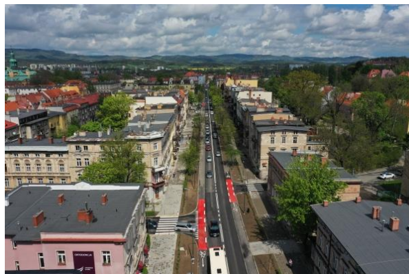
Przebudowa ul. Wojska Polskiego
