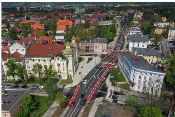
Przebudowa wejścia do Teatru im C.K. Norwida
