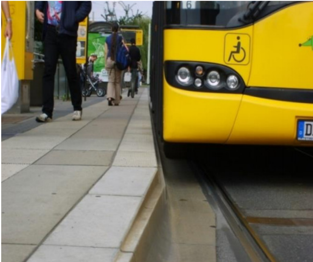
Rys. 9.3 Zalecane ukształtowanie podniesionej krawędzi peronowej
