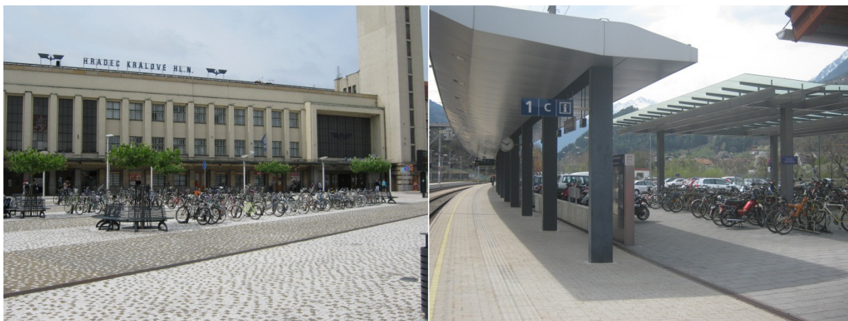
Rys. 12.3. Zdjęcie po lewej przedstawia stojaki rowerowe w systemie „bike and ride” przed dworcem kolejowym Hradec Králové hlavní nádraží w Czechach. Na zdjęciu po prawej zaprezentowano stojaki rowerowe zamontowane bezpośrednio przy peronie kolejowym na dworcu w Landeck w Austrii.
