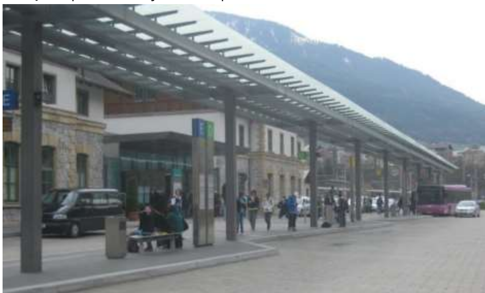
Rys. 12.2 Perony autobusowe przed dworcem kolejowym w miejscowości Landeck (Austria)
