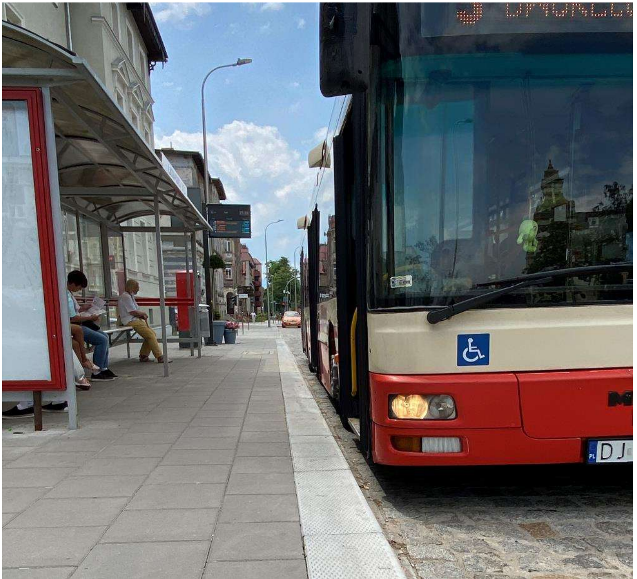
Rys. 9.3 Zalecane ukształtowanie podniesionej krawędzi peronowej
