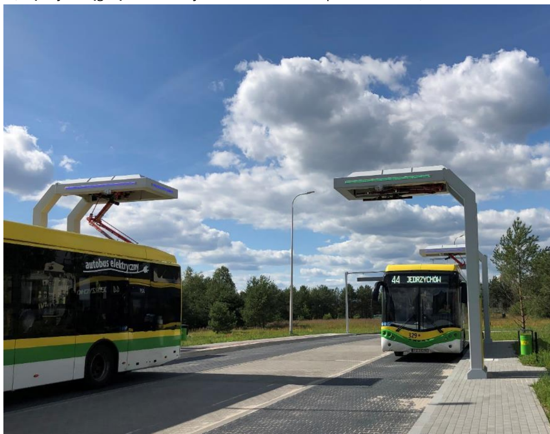
Rys. 4.2 Ładowanie autobusu elektrycznego akumulatorowego z ładowarki pantografowej w Zielonej Górze
