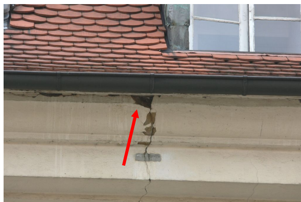
Fot. 2. Potencjalne miejsce gniazdowania jerzyka na frontowej ścianie budynku.
