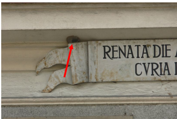
Fot. 1. Miejsce gniazdowania jaskółki oknówki – nad wejściem głównym do ratusza.
