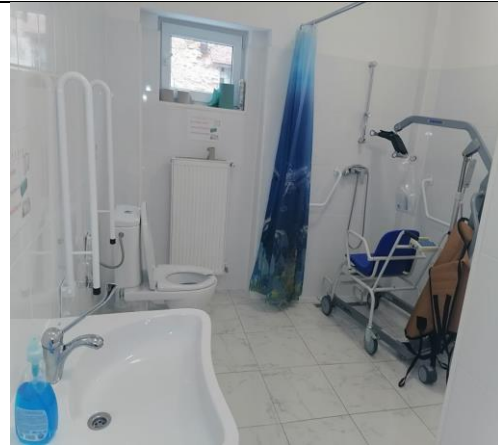
Fot. Zaplecze sanitarne w nowej siedzibie
