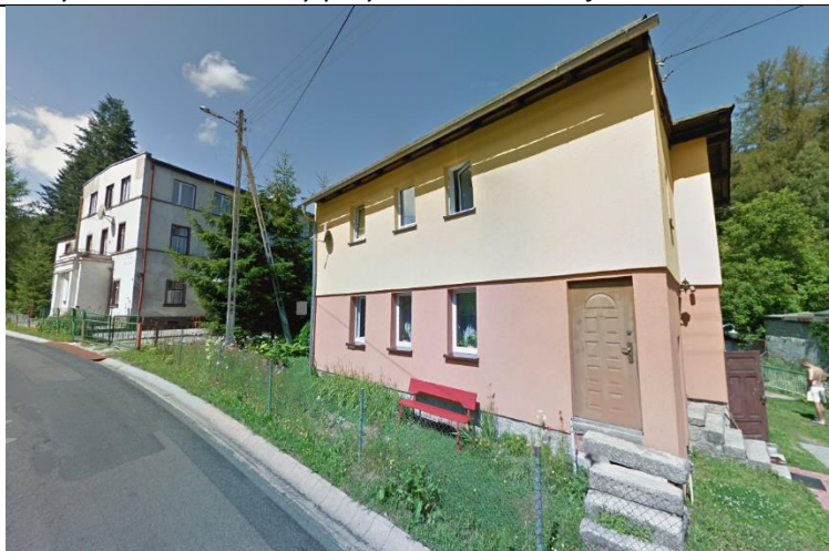
Fot. 11. Budynek przy ul. Michałowickiej
