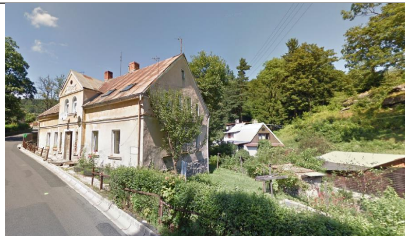
Fot. 10. Budynek przy ul. Michałowickiej
