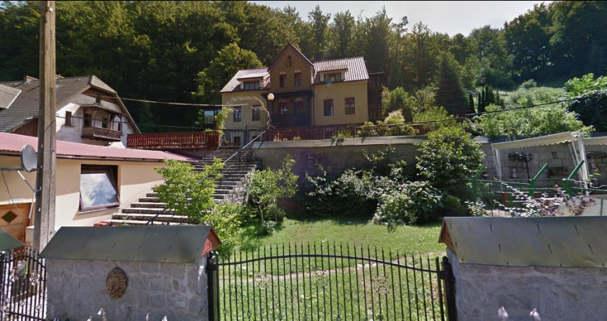
Fot. 7. Budynek hotelu przy ul. Agnieszkowskiej
