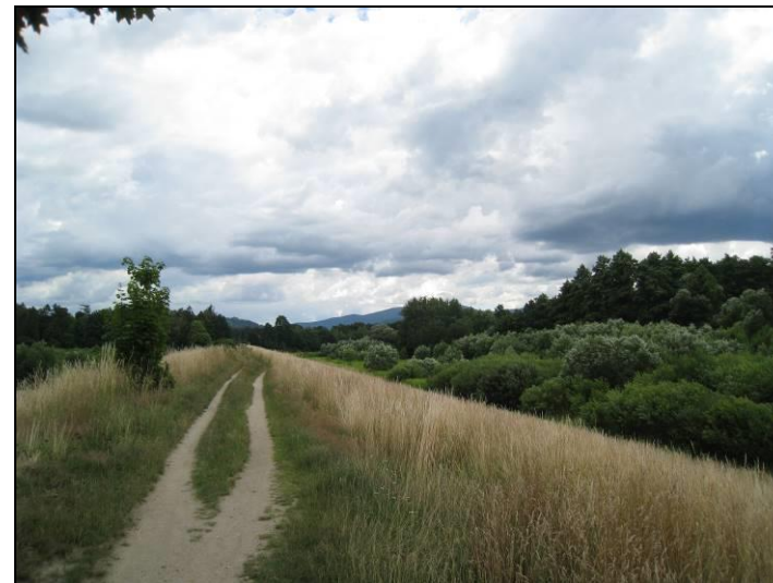
Fot. 3 Widok na suchy zbiornik przeciwpowodziowy Cieplice teren nr 2
