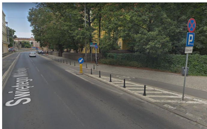
Ryc. 33 Zjazd z drogi dla rowerów na jezdnię. Źródło: GoogleStreetView
