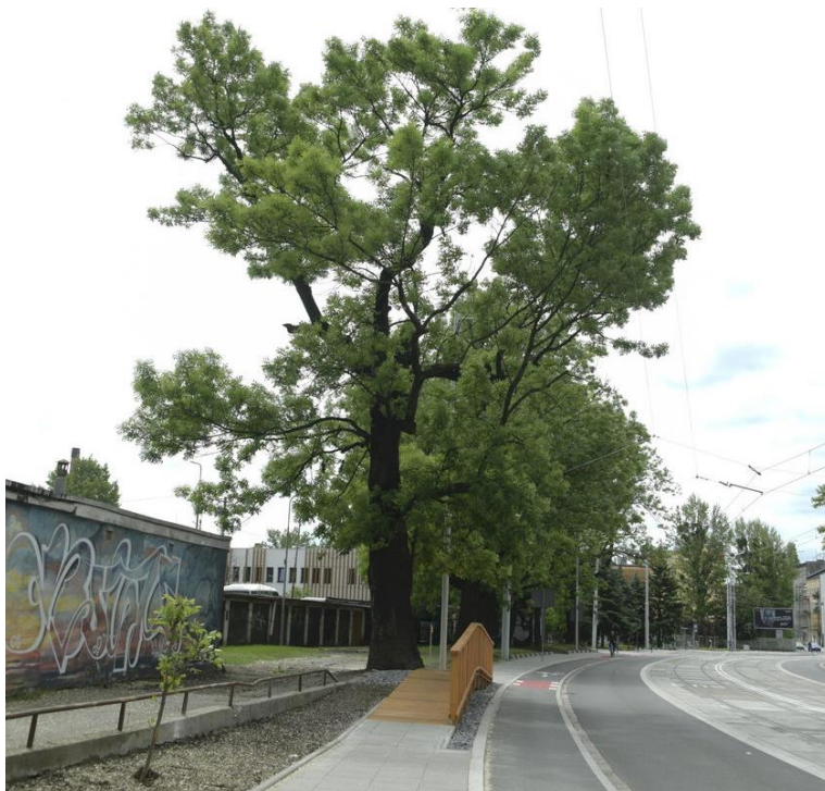
Ryc. 36 Kładka wyniesiona ponad system korzeniowy. Źródło: Zbudowali kładkę i uratowali drzewo (fakt.pl)
