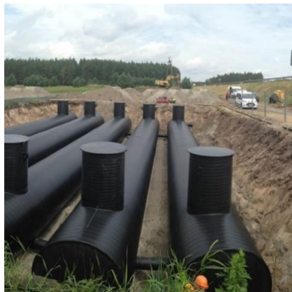
Ryc. 11 Zbiorniki podziemne, źródła (od lewej): https://www.uponor.pl ; https://ecol-unicon.com/produkty/produkty-deszczowe/zbiorniki-retencyjne-hydrozone/
