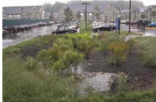
Ryc. 7 Przykład zbiornika chłonnego odbierającego wodę z ulic i parkingu, (Iwona Wagner, 2014)
