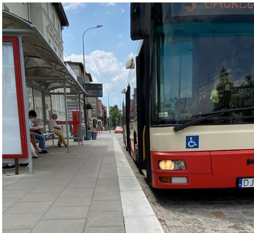
Rys. 9.3 Zalecane ukształtowanie podniesionej krawędzi peronowej Źródło: Zbiory własne
