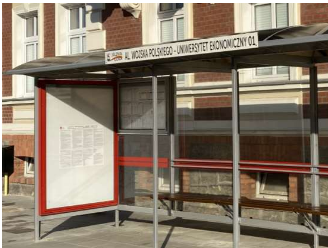
Rys. 11.1 Przykład poprawnego oznakowania przystanku komunikacyjnego w Jeleniej Górze Źródło: Zbiory własne
