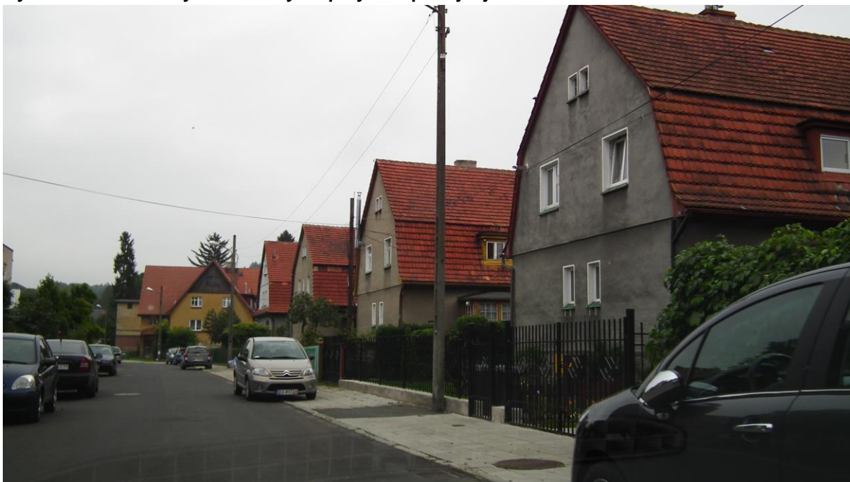
Ryc. 5 Widok na zabytkowe budynki przy ul. Spokojnej
