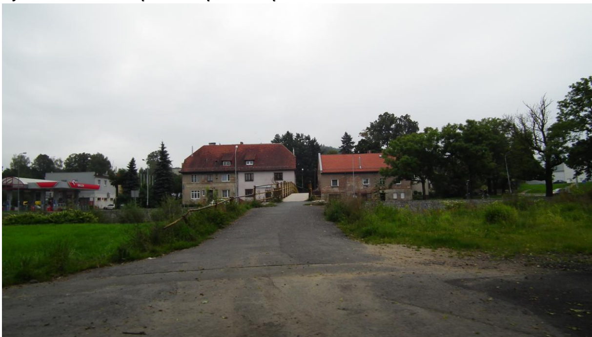
Ryc. 4 Widok na kładkę nad rzeką Kamienną
