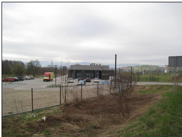
Fot. 1 Widok w kierunku południowym, obiekt „Kolejkowa” w trakcie realizacji
