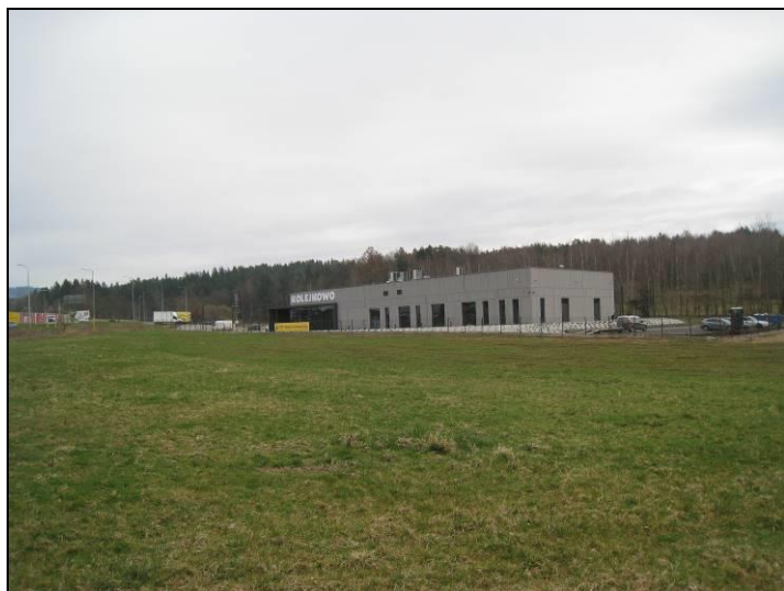
Fot. 5 Obiekt „Kolejkowa” widziany od strony południowo-zachodniej
