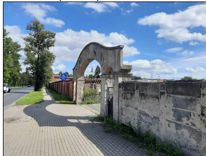
Fot. 4 Ogrodzenie terenu nr 2
