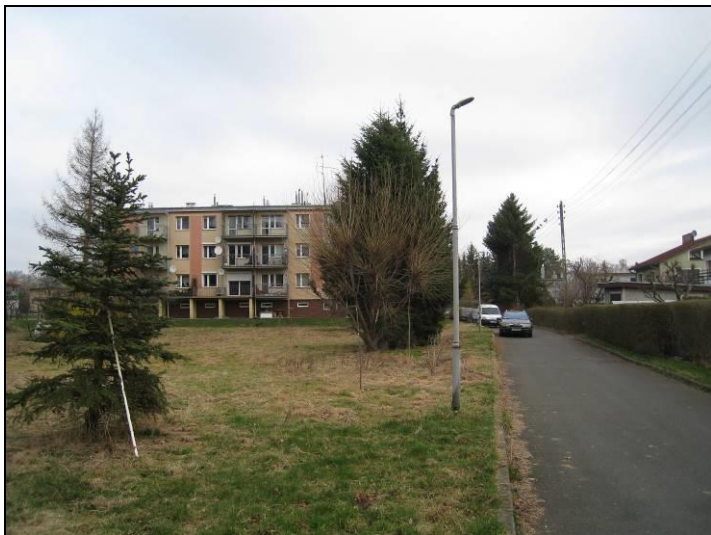
Fot. 1 Analizowany teren, widok w kierunku północnym i na ul. G. Zapolskiej
