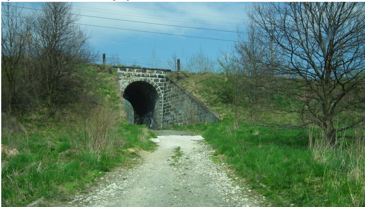
Ryc. 6 Widok na wiadukt kolejowy
