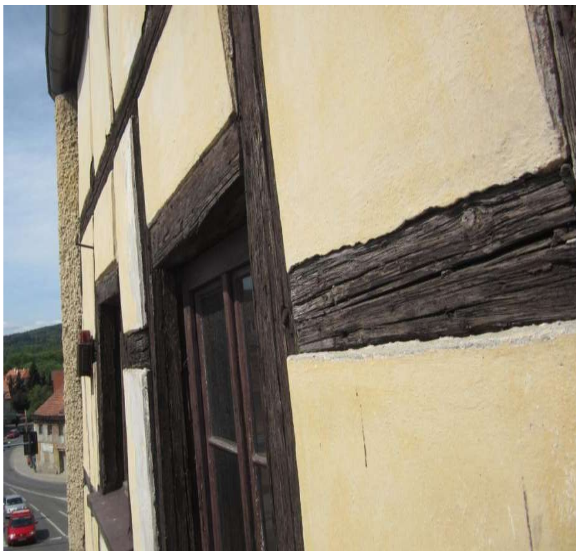
Rys. 53. Szczegóły uszkodzeń wybranych drewnianych elementów muru pruskiego
