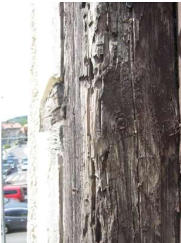
Rys. 57. Szczegóły uszkodzeń wybranych drewnianych elementów muru pruskiego
