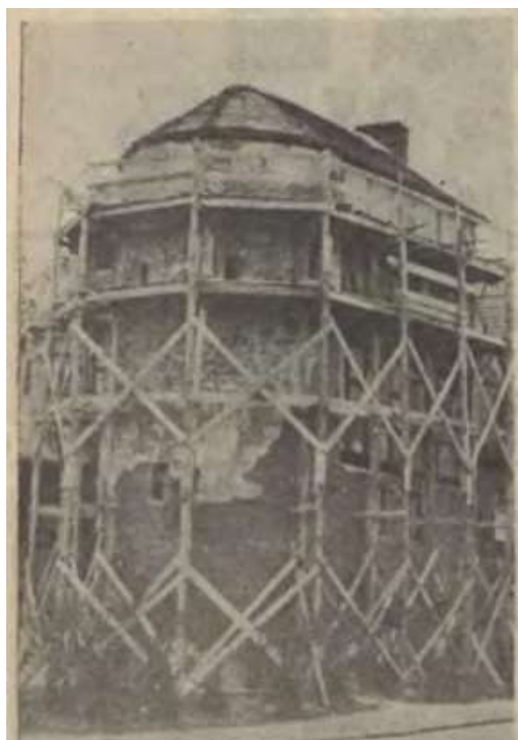
Rys. 22. Fotografia Baszty Grodzkiej z 1959 r. (skucie odpadających tynków)
