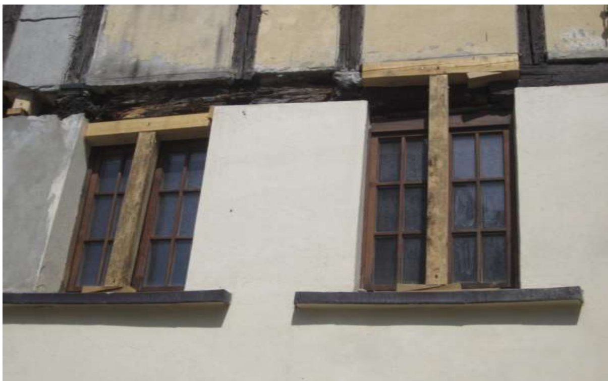
Rys. 47. Widok uszkodzonej belki podwalinowej muru pruskiego
