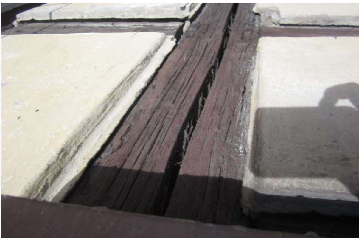
Rys. 54. Szczegóły uszkodzeń wybranych drewnianych elementów muru pruskiego
