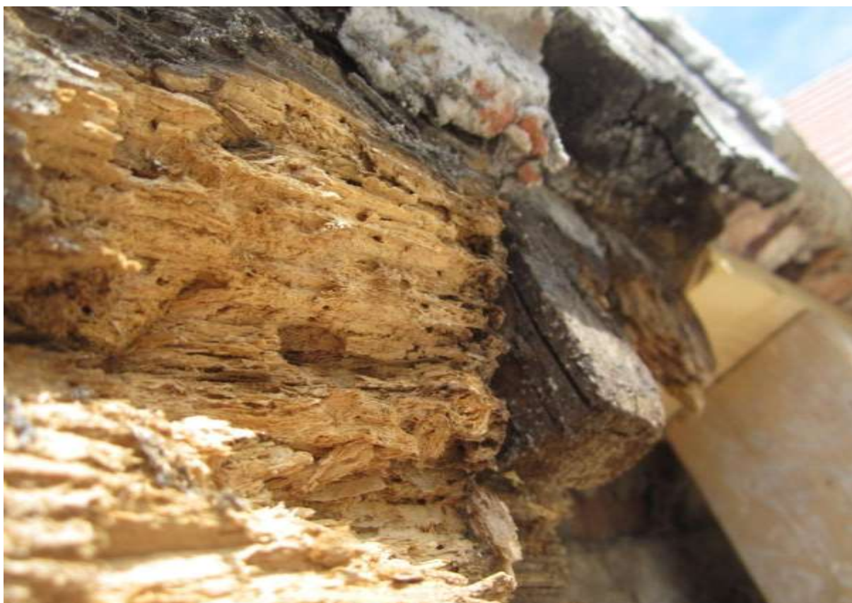
Rys. 49. Szczegół uszkodzonej belki podwalinowej muru pruskiego
