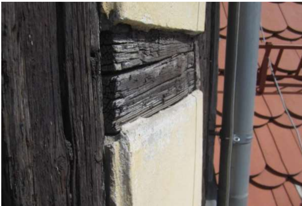
Rys. 55. Szczegóły uszkodzeń wybranych drewnianych elementów muru pruskiego
