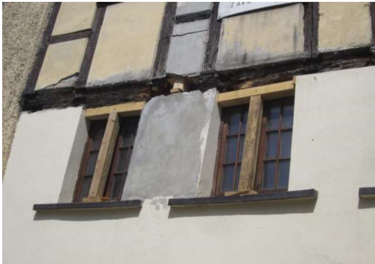
Rys. 46. Widok uszkodzonej belki podwalinowej muru pruskiego
