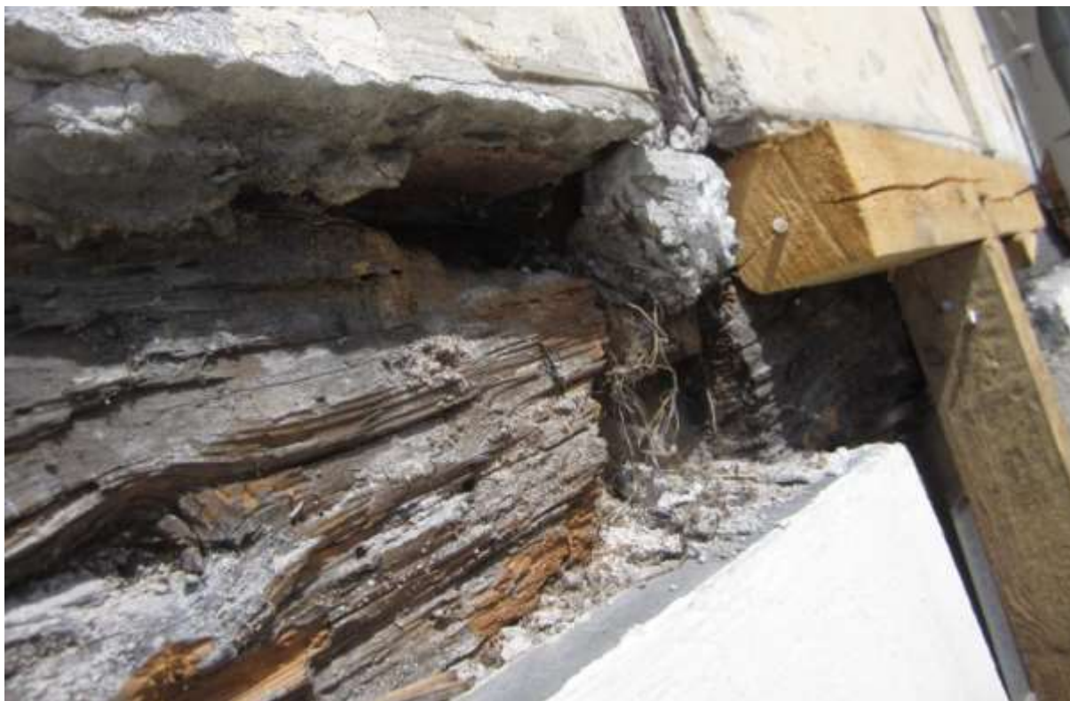
Rys. 50. Szczegół uszkodzonej belki podwalinowej muru pruskiego
