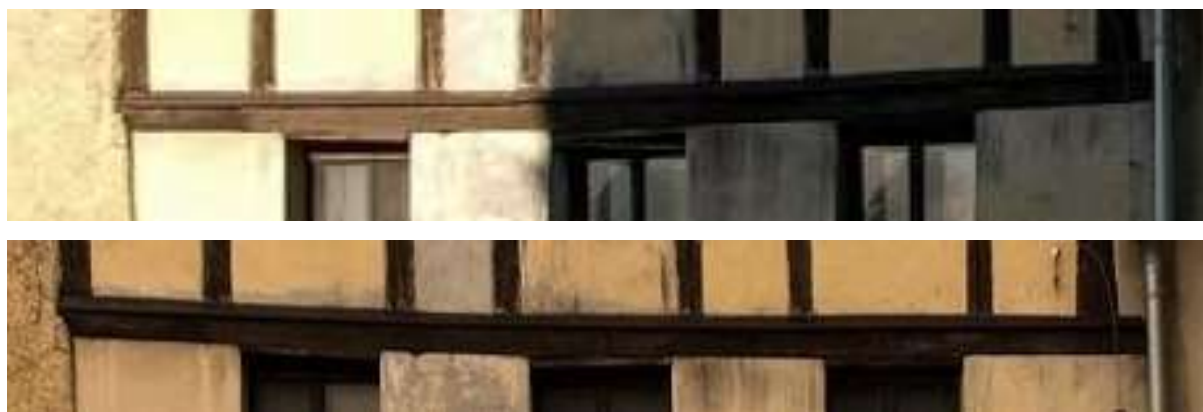
Rys. 62. Atrapa belki podwalinowej założona na uszkodzonej belce. Widok z 2009 r. (góra) i z 2012 r. (dół)
