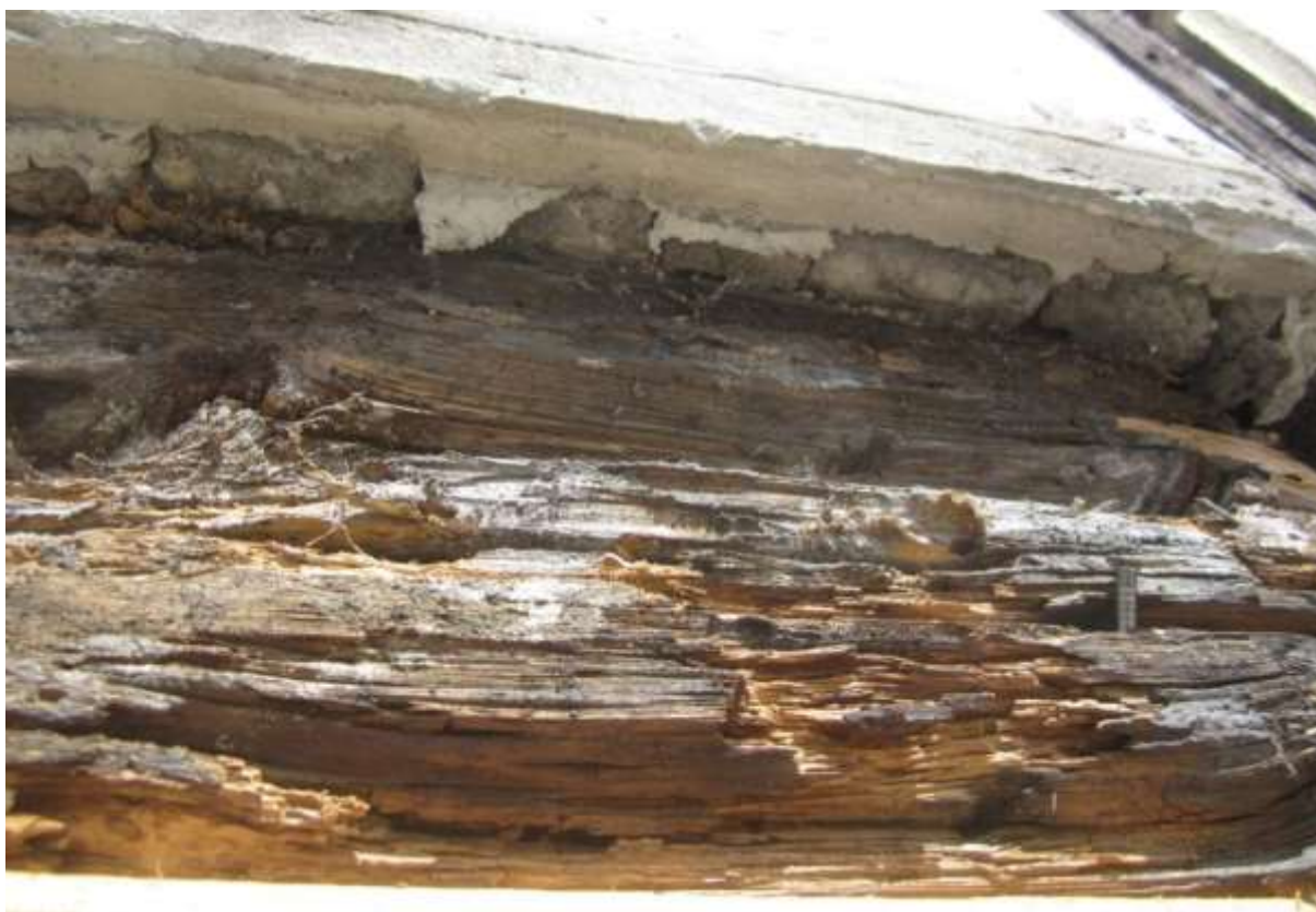
Rys. 48. Szczegół uszkodzonej belki podwalinowej muru pruskiego
