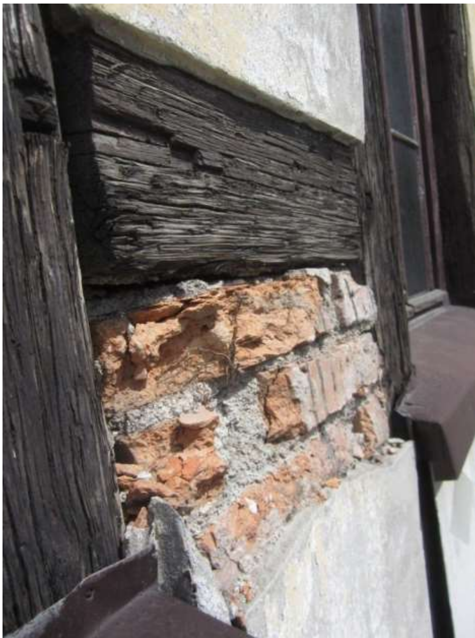
Rys. 58. Szczegóły uszkodzeń wybranych drewnianych elementów muru pruskiego
