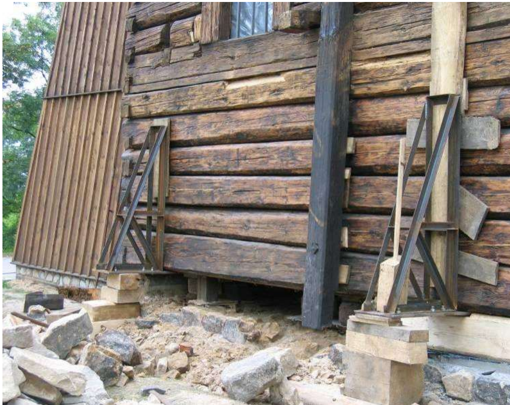
Rys. 63. Idea konstrukcji podpierającej na przykładzie wymiany belki podwalinowej ściany drewnianej
