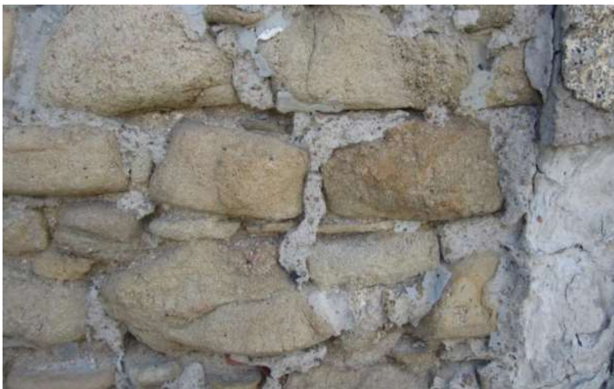
Rys. 59. Niezgodne ze sztuką konserwatorską spoinowanie muru kem innego zaprawą cementową
