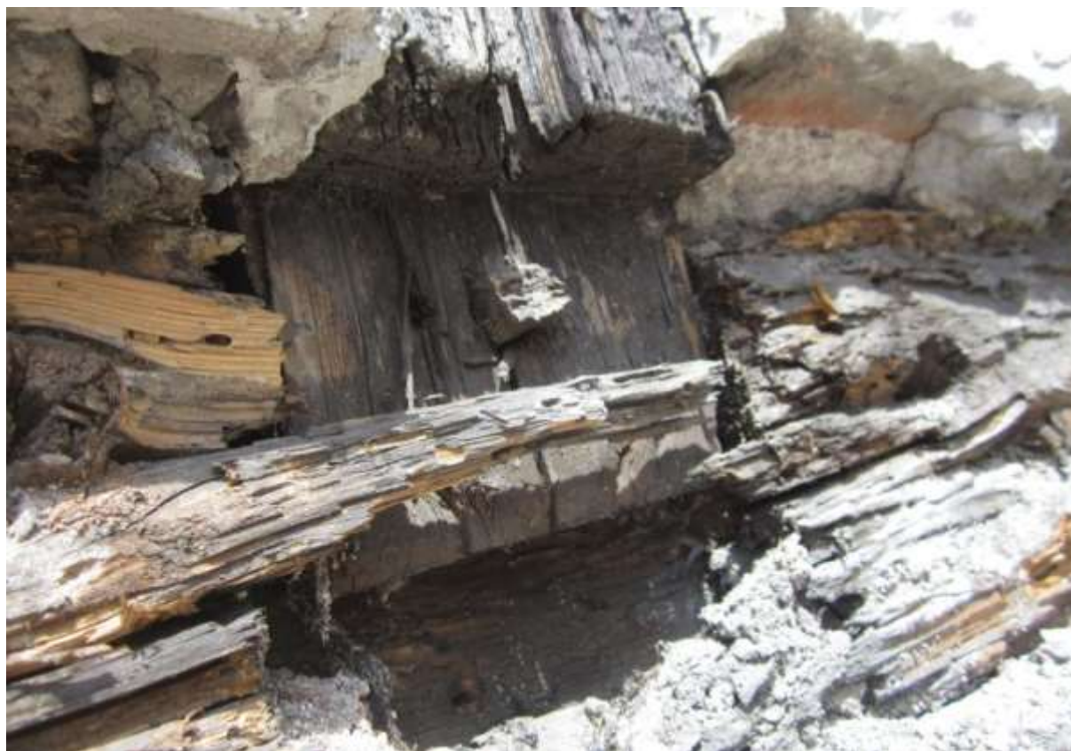
Rys. 52. Szczegół uszkodzonej belki podwalinowej muru pruskiego
