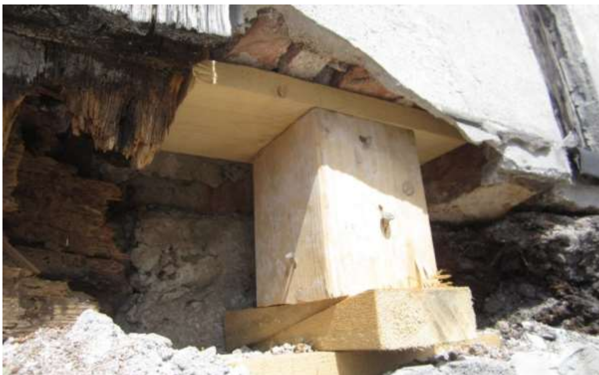
Rys. 41. Widok muru za belką podwalinową muru pruskiego
