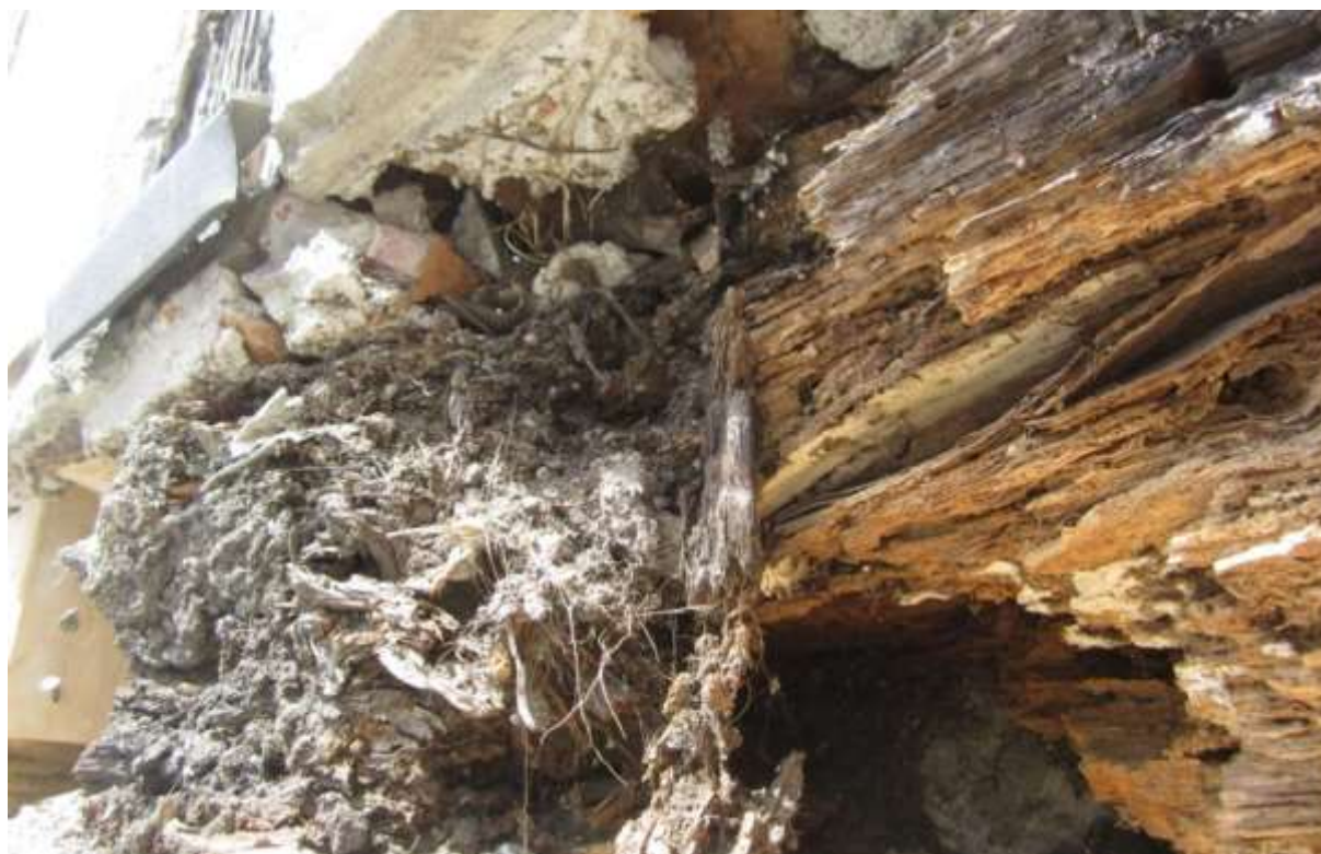
Rys. 51. Szczegół uszkodzonej belki podwalinowej muru pruskiego
