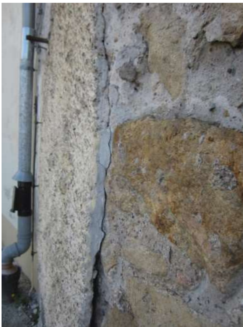
Rys. 61. Odspojenia tynku od kamiennego muru półbaszty
