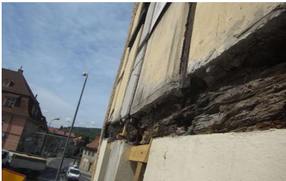
Rys. 45. Widok uszkodzonej belki podwalinowej muru pruskiego
