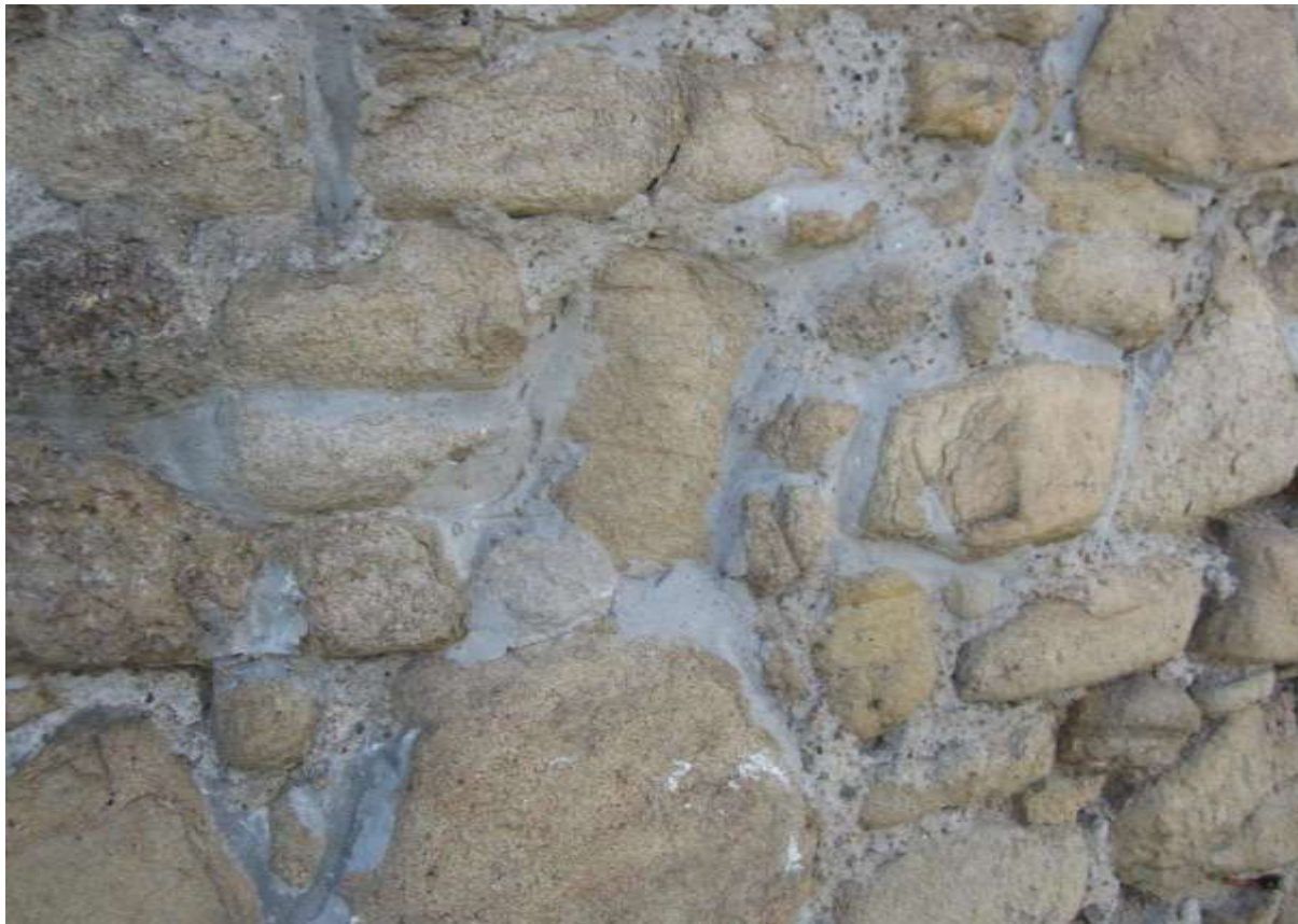
Rys. 60. Niezgodne ze sztuką konserwatorską spoinowanie muru kem innego zaprawą cementową
