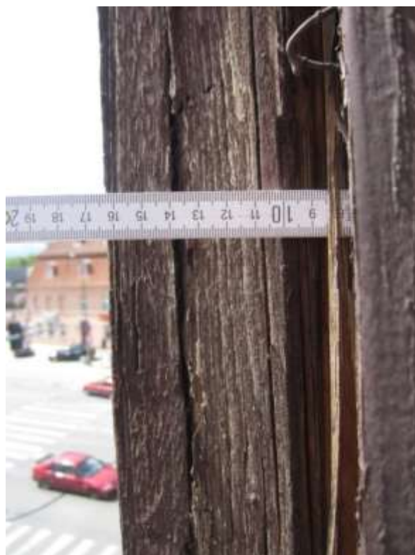
Rys. 56. Szczegóły uszkodzeń wybranych drewnianych elementów muru pruskiego
