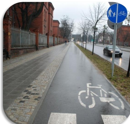
Zdjęcie 28. Toruń. Oddzielenie drogi dla rowerów od jezdni pasem zieleni, a od chodnika brukowaną opaską.
