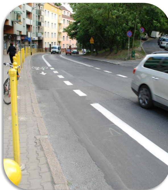
Zdjęcie 12. Szczecin, ul. Piotra Skargi. Pas ruchu dla rowerów po jednej stronie ulicy ze spadkiem podłużnym.
