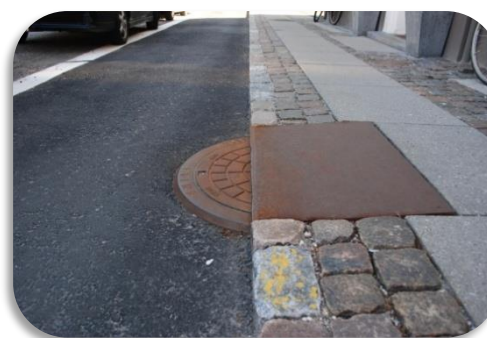
Zdjęcie 36. Dania, Kopenhaga. Studzienka pomiędzy obniżoną drogą dla rowerów a chodnikiem.
