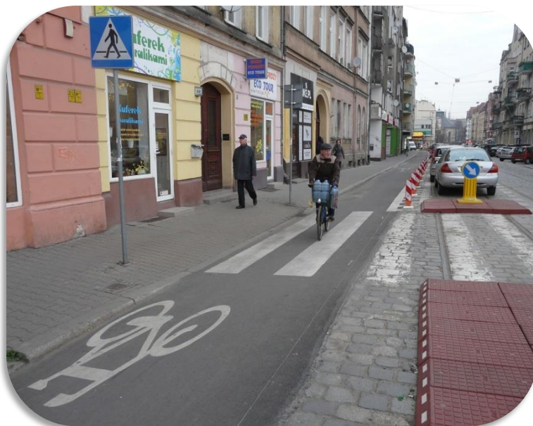
Zdjęcie 18. Polska, Wrocław. Asfaltowy kontrapas na jezdni z kostki kamiennej.
