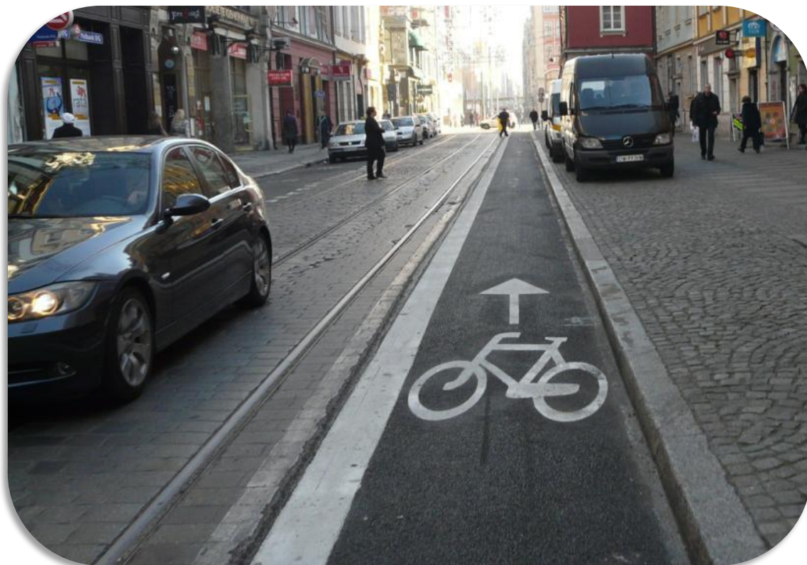
Zdjęcie 44. Polska, Wrocław. Asfaltowy pas rowerowy na jezdni z kostki kamiennej.
