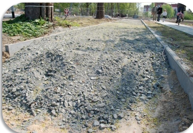
Zdjęcie 39. Szczecin. Podbudowa pod nawierzchnię bitumiczną drogi dla rowerów.
