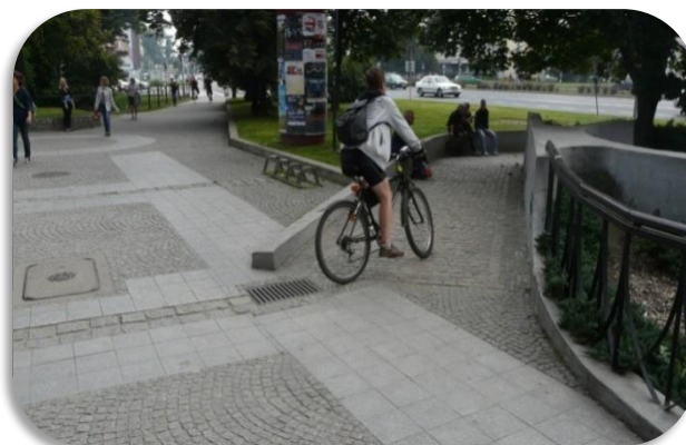
Zdjęcie 43. Polska, Wrocław. Ułożenie wpustu w ciągu trasy rowerowej.
