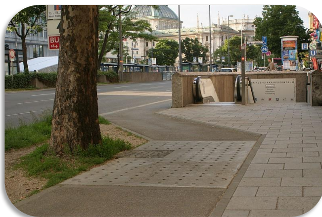
Zdjęcie 41. Niemcy, Berlin. Płyta betonowa z otworami przykrywająca system korzeniowy.
