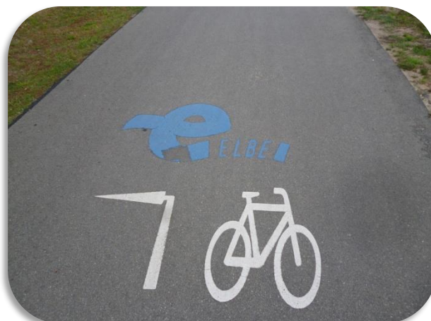
Zdjęcie 89. Niemcy, trasa w ciągu Łaby. Oznakowanie poziome.
