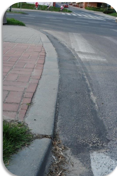
Zdjęcie 90. Klin z masy bitumicznej ułatwiający podjazd na krawężnik - rozwiązanie tymczasowe.
