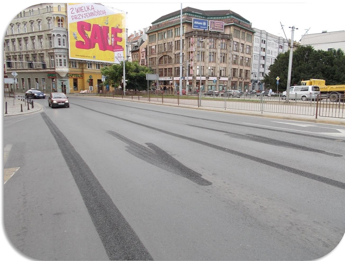
Zdjęcie 83. Polska, Wrocław. Usuwanie oznakowania poziomego wodą pod ciśnieniem.
