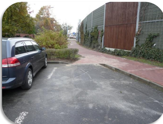
Zdjęcie 73. Polska, Wrocław. Wjazd z jezdni na drogę dla rowerów.
