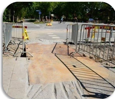
Zdjęcie 91. Turku, Finlandia. Tymczasowa nawierzchnia z płyty stalowej.
