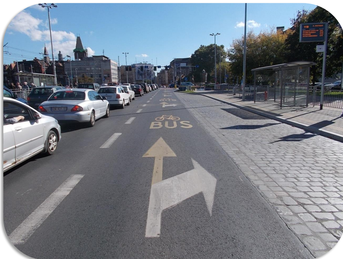
Zdjęcie 86. Polska, Wrocław. Pas ruchu do skrętu w prawo z dopuszczonym ruchem rowerowym na wprost.
