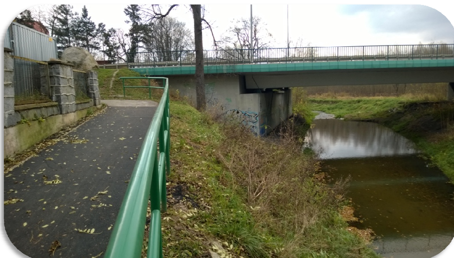
Zdjęcie 7. Ulica Jana Pawła II – brak połączenia pod mostem.
