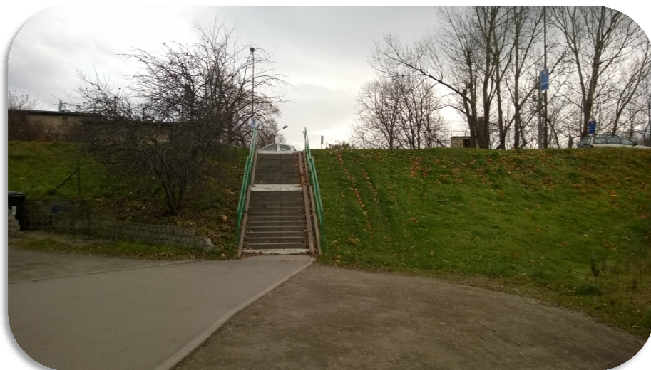
Zdjęcie 8. Ulica Wiejska – brak ciągłości trasy rowerowej w ciągu Bobru.
