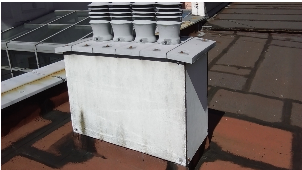
Fot.15. Dachu budynku część C. Widok na komin obity płytami.
