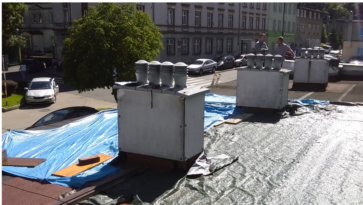
Fot.15. Dach budynku część C. Widok ogólny na kominy i zabezpieczenia miejsc przecieków.
