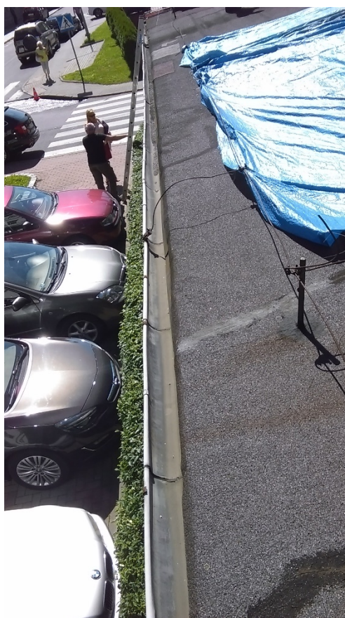
Fot.16. Dach budynku część C. Widok ogólny pasa nadrynnowego .
