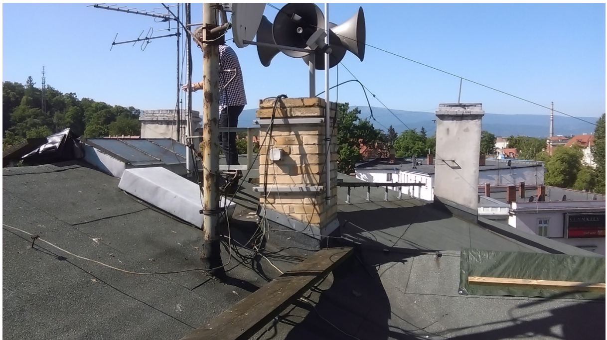
Fot.10. Dach budynku część A. Część kalenicowa- widok ogólny .
