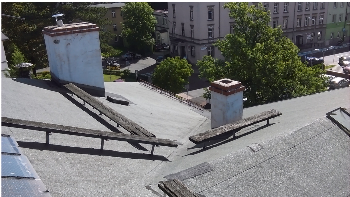
Fot.4. Dachu budynku część A. Widok ogólny na kominy, ławy kominiarskie i połąć od strony ulicy Ptasiej .
