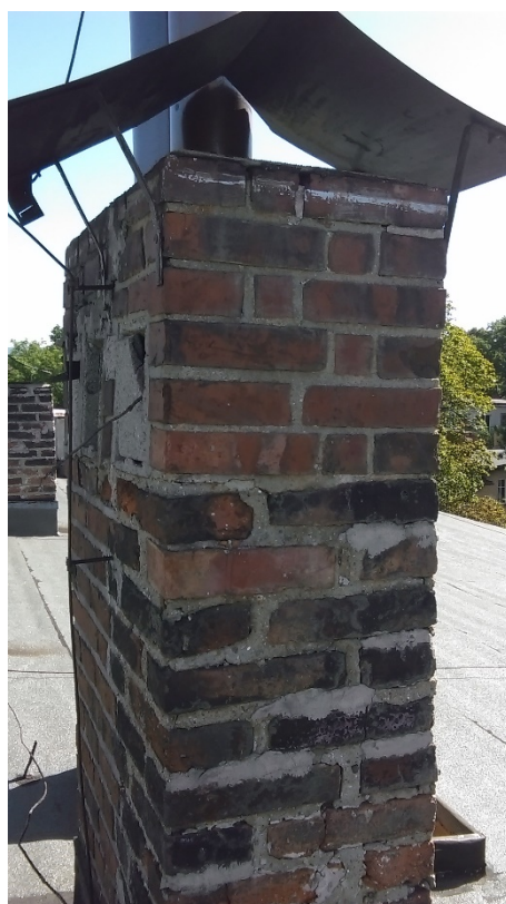
Fot.12. Dachu budynku część B. Komin środkowy przewidziany do wymiany .
