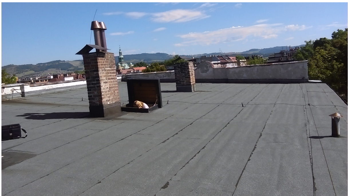
Fot.14. Dach budynku część B. Widok ogólny .
