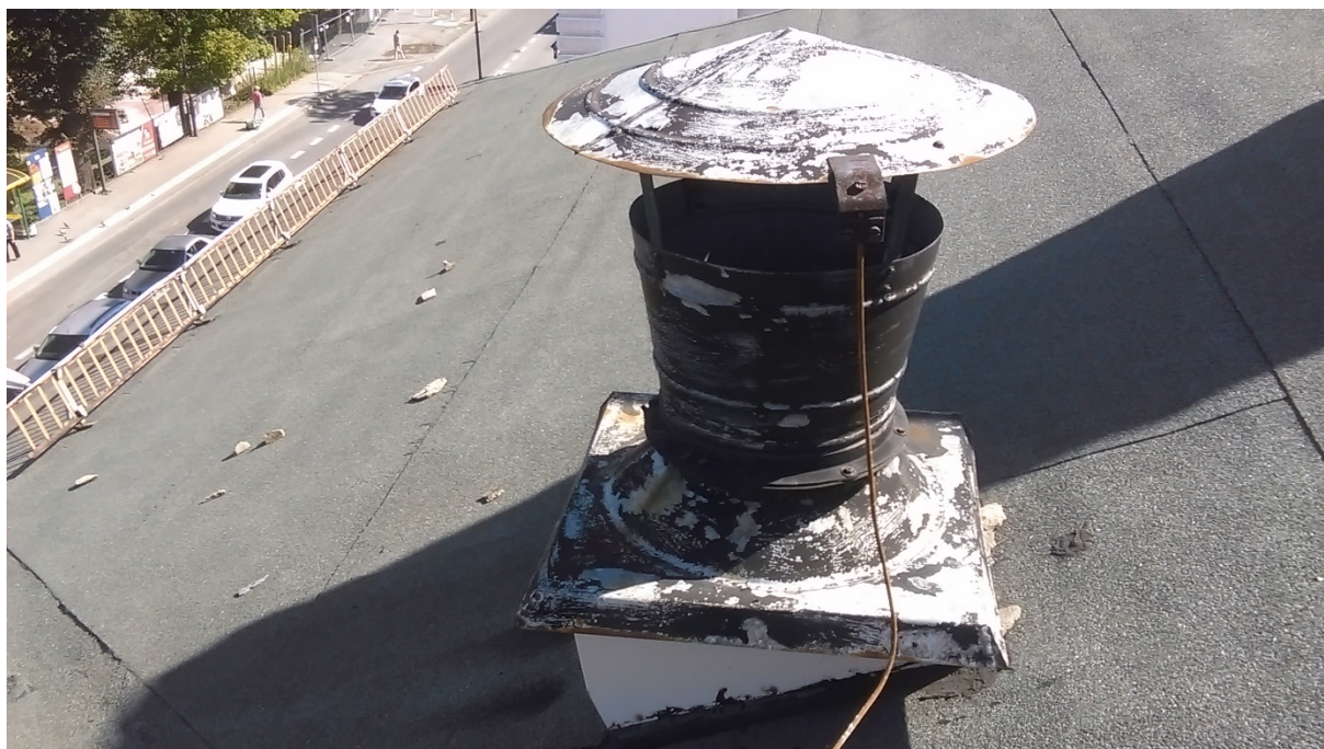
Fot.7. Dachu budynku część A. Komin wentylacyjny .
