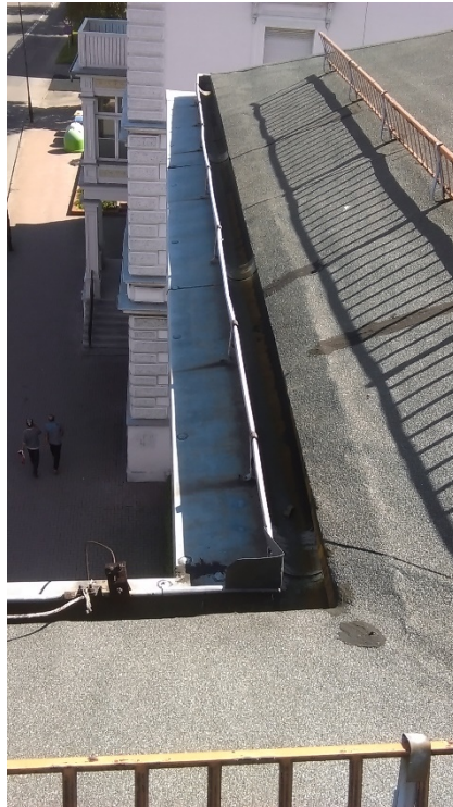
Fot.5. Dachu budynku część A. Widok ogólny na obróbkę gzymsu i rynnę leżącą .
