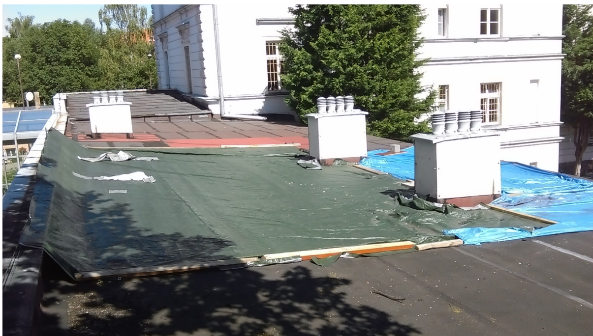
Fot.17. Dachu budynku część C. Widok ogólny w kierunku ulicy Wojska Polskiego .
