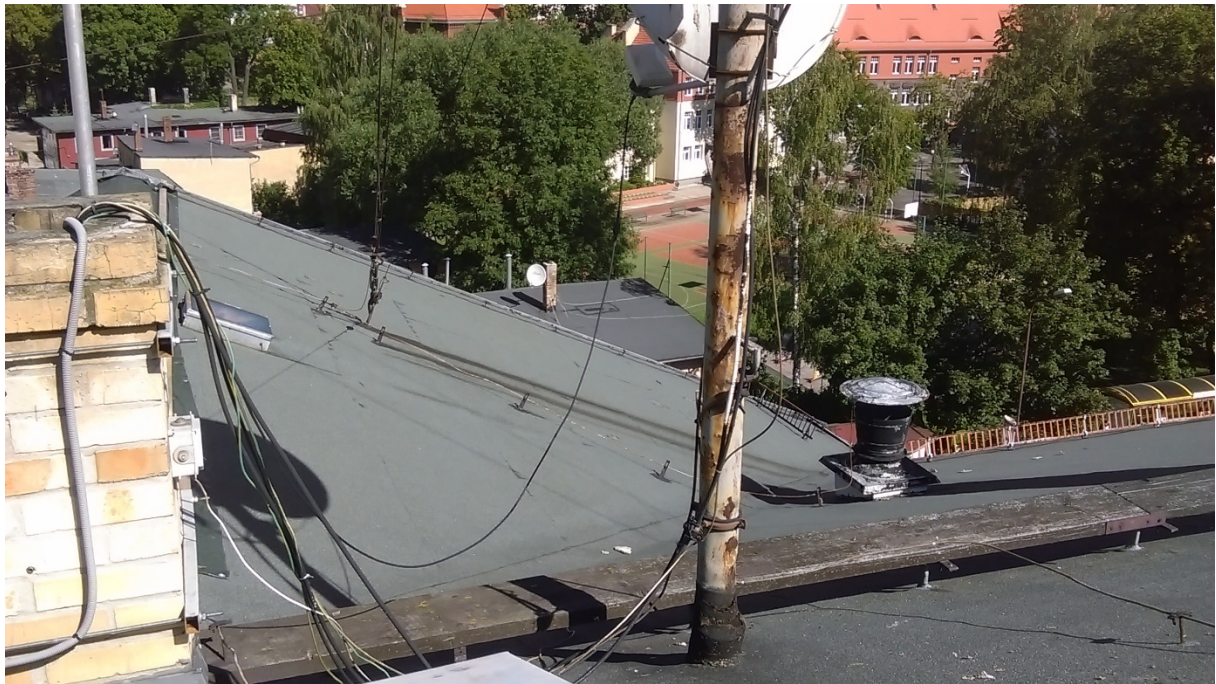
Fot.1. Dach budynku część A. Widok ogólny od strony ulicy Wojska Polskiego
