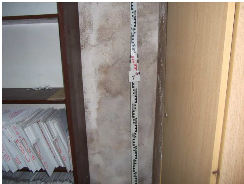
Fot. 4 Pomieszczenie archiwum wydz. Komunikacji - widoczne ślady zagrzybienia.
