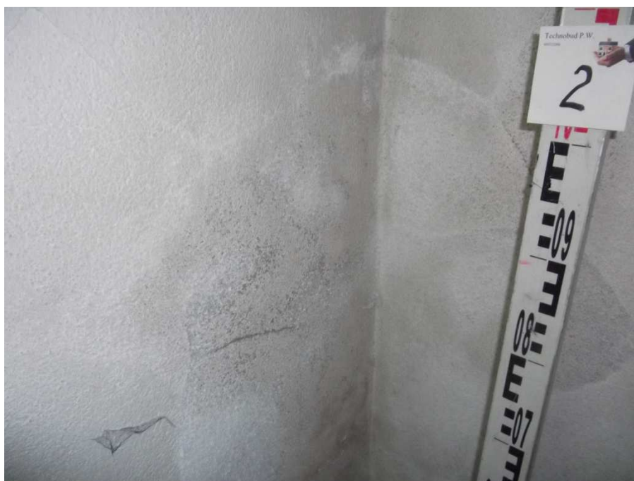
Fot. 10 Pomieszczenie nr.2 -korytarz, widoczne ślady wysolenia
