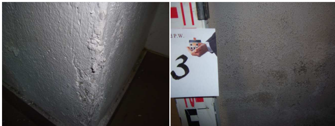
Fot. 12 Fot. 13 Łuszczenie się tynku spowodowane obecnością związków soli mineralnych.
