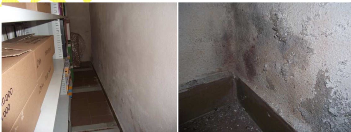
Fot. 23 Fot. 24 Skorodowane przez wilgoć ściany pomieszczenia nr.5
